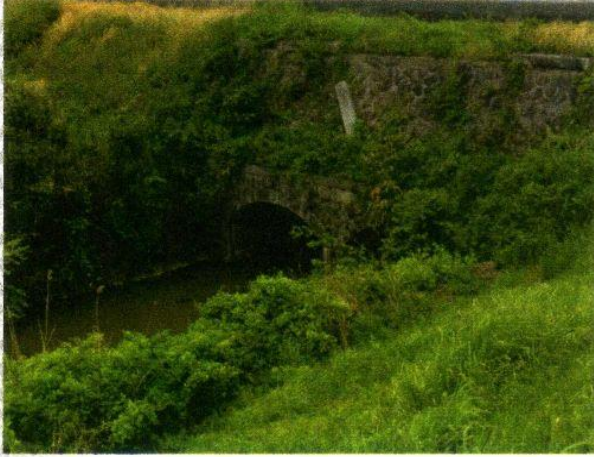
▲五箇村川と樋門
