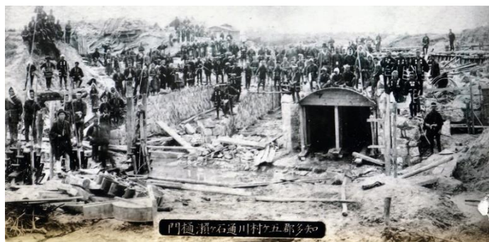
石ヶ瀬樋門工事(長七たたき)
