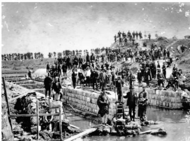
皆瀬樋門工事(長七たたき)
